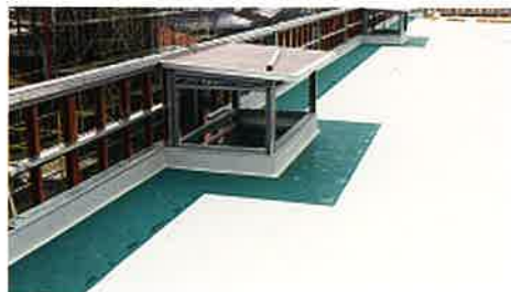
鳥栖プレミアムアウトレット現場でのメンテナンス通路部分施工中(写真左)と施工後(写真右)
