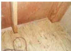
土台周りの状況
